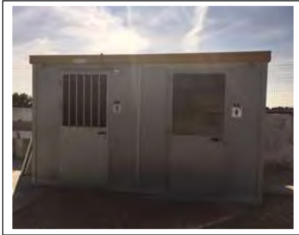
Foto 7_Area A-modulo prefabbricato 1
