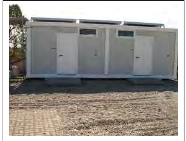
Foto 8_Area A-modulo prefabbricato 2
