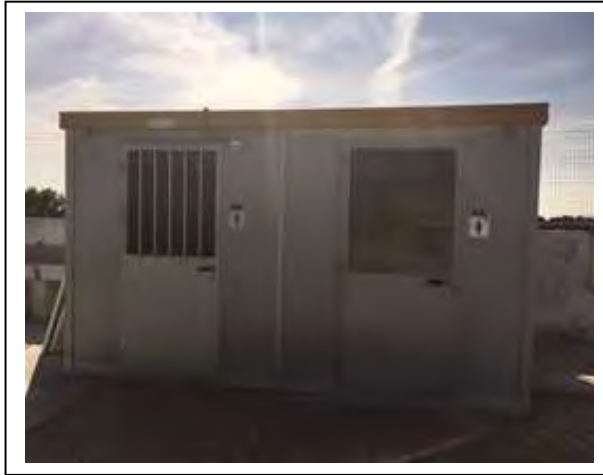
Foto 7_Area A-modulo prefabbricato 1
