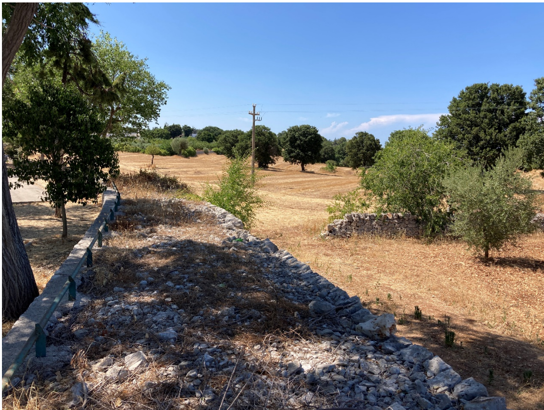
(FIGURA G – FOTO DA SOPRALLUOGO)
