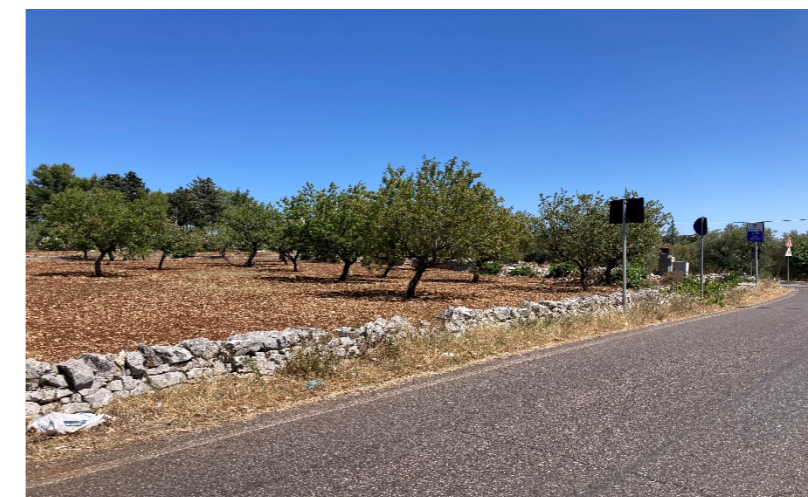
Figura 8 - Foto da sopralluogo
